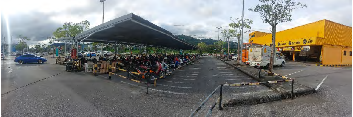
สภาพสิ่งปลูกสร้างอื่นๆ / ที่จอดรถยนต์ (หลังคาคลุม) และที่จอดรถจักรยานยนต์ (หลังคาคลุม)
