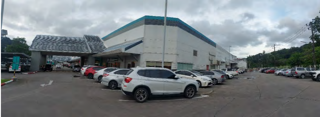
สภาพทั่วไปสิ่งปลูกสร้างรายการที่ 1 / อาคารโลตัสไฮเปอร์มาร์เก็ตชั้นเดียว พร้อมชั้นลอย
