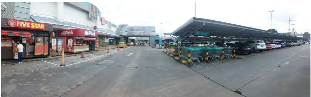
สภาพสิ่งปลูกสร้างอื่นๆ / ที่จอดรถยนต์ (หลังคาคลุม)
