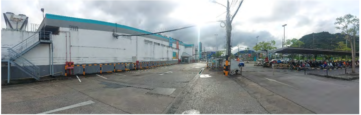
สภาพสิ่งปลูกสร้างอื่นๆ / ถนนและลานคอนกรีต
