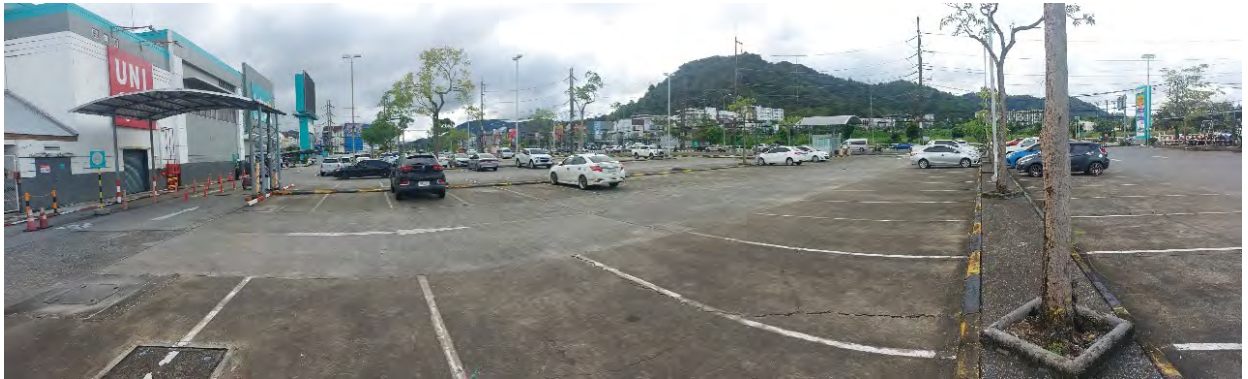
สภาพสิ่งปลูกสร้างอื่นๆ / ถนนและลานคอนกรีต
