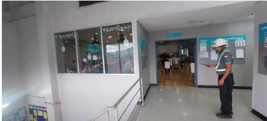
ภาพทั่วไปภายในสิ่งปลูกสร้างรายการที่ 1 / บริเวณส่วนพื้นที่สำนักงาน (Office Area) ชั้นลอย
