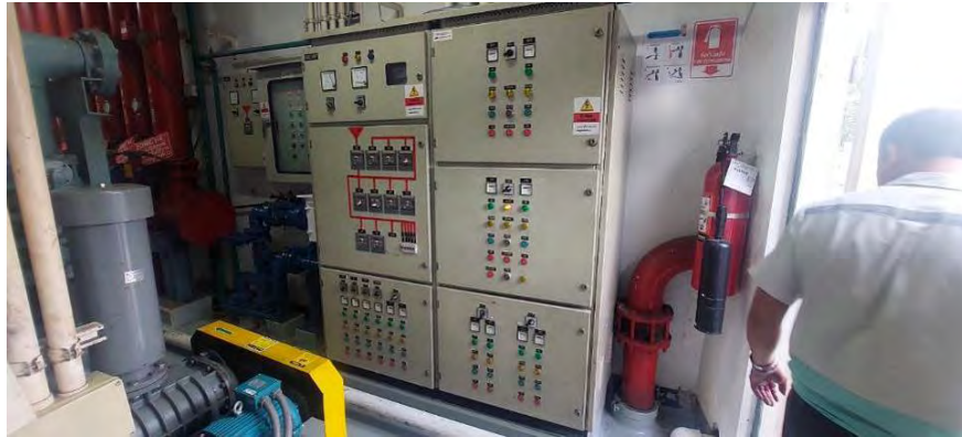
สภาพทั่วไปพื้นที่งานระบบอาคารห้องปั้มน้ำระบบดับเพลิง (Water Pump-Fire Pump)
