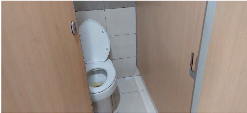
สภาพทั่วไปภายในสิ่งปลูกสร้างรายการที่ 1 / บริเวณห้องน้ำ / ชั้นลอย
