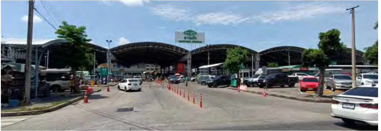
อาคารตามสัญญาเช่าที่จดทะเบียน : สภาพอาคารลำดับที่ 17 อาคารคลุมลานผัก
