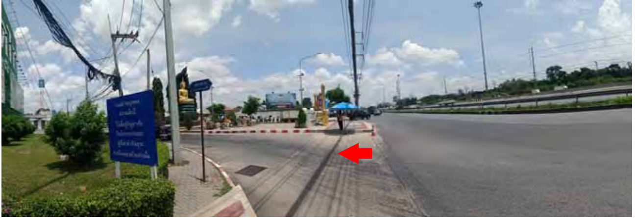
สภาพถนนพลโยธิน บริเวณแยกเข้าโครงการตลาดไท (จุดถ่ายภาพที่ 1)
