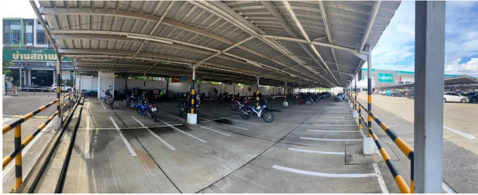
สภาพทั่วไปสิ่งปลูกสร้างรายการอื่นๆ หลังคาคลุมจอดรถ
