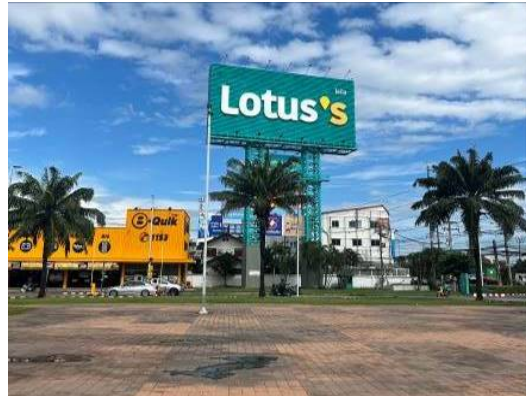
สภาพทั่วไปสิ่งปลูกสร้างรายการอื่นๆ ป้าย
