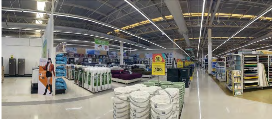
สภาพภายในอาคาร ชั้นบน บริเวณพื้นที่ไฮเปอร์มาร์เก็ต (Hypermarket)
