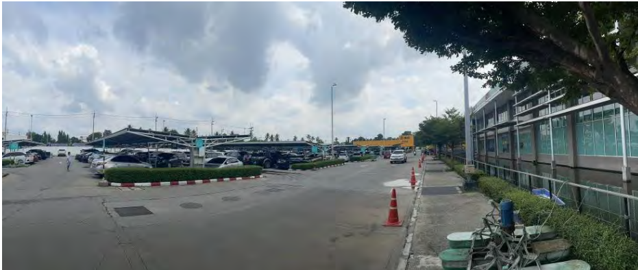
สภาพสิ่งปลูกสร้างอื่นๆ / ที่จอดรถยนต์ (หลังคาคลุม) และที่จอดรถจักรยานยนต์ (หลังคาคลุม)
