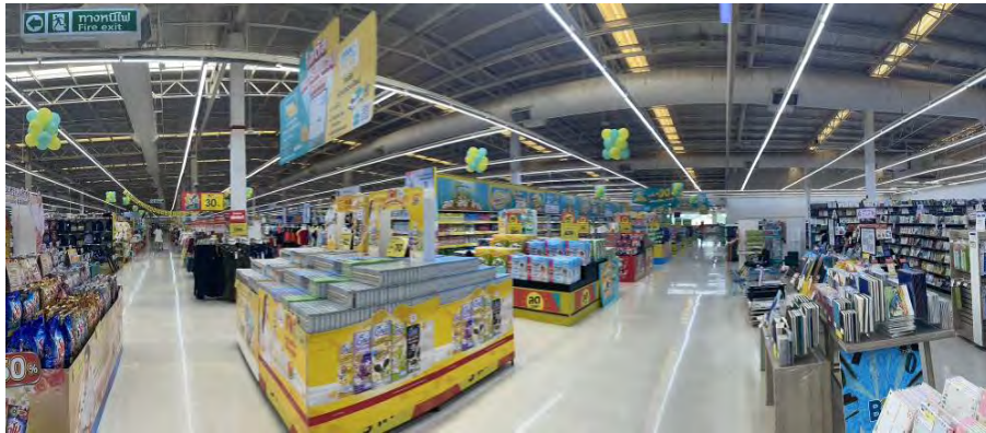
สภาพภายในอาคาร ชั้นบน บริเวณพื้นที่ไฮเปอร์มาร์เก็ต (Hypermarket)
