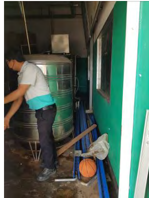
สภาพสิ่งปลูกสร้างอื่นๆ / อาคารพลังงานแสงอาทิตย์
