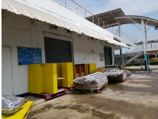
สภาพสิ่งปลูกสร้างอื่นๆ / อาคารพลังงานแสงอาทิตย์
