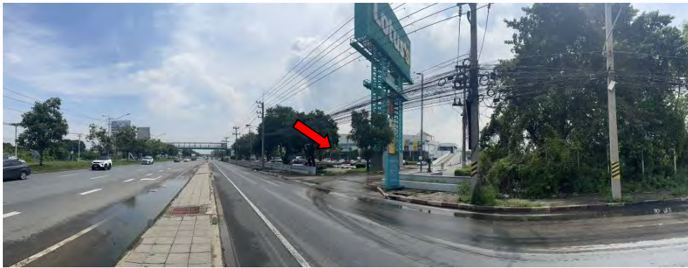
จุดถ่ายภาพที่ 2 : สภาพถนนบรมราชชนนี (ทล.338) บริเวณผ่านด้านหน้าทรัพย์สินที่ประเมินมูลค่า ภายใต้ชื่อ "โลตัส ไฮเปอร์มาร์เก็ต สาขาศาลายา"
