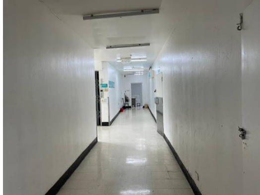
สภาพภายในอาคาร ชั้นลอย บริเวณพื้นที่ร้านค้าให้เช่า (Mall Area)
