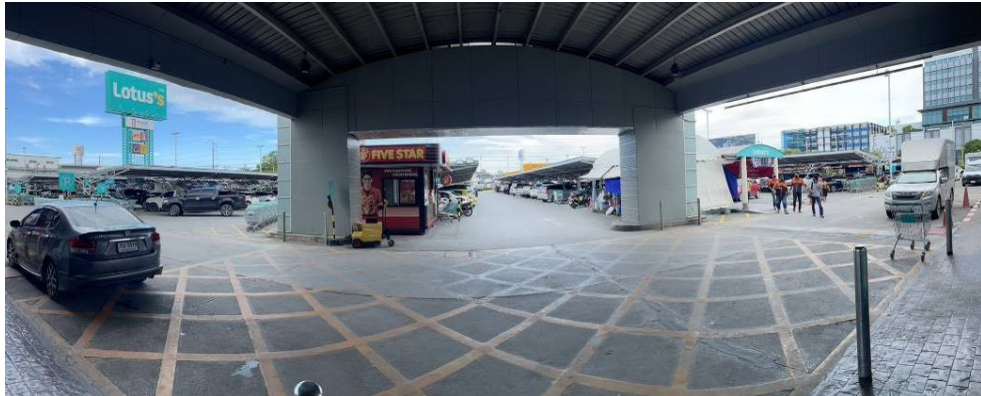
สภาพบริเวณด้านหน้าประตูทางเข้า-ออกอาคารโลตัส ไฮเปอร์มาร์เก็ตชั้นเดียว มีชั้นลอย
