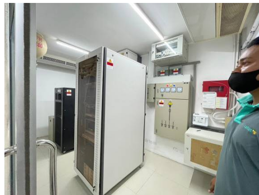
สภาพภายในอาคารฯ ชั้นล่าง บริเวณพื้นที่สำนักงาน (Back Office)
