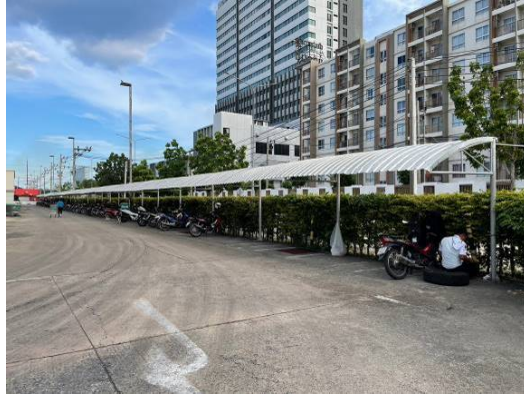
สภาพสิ่งปลูกสร้างอื่นๆ / ที่จอดรถจักรยานยนต์ (หลังคาคลุม)
