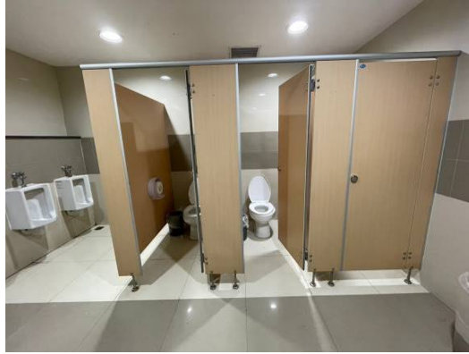
สภาพภายในอาคารฯ ชั้นลอย / ห้องน้ำ
