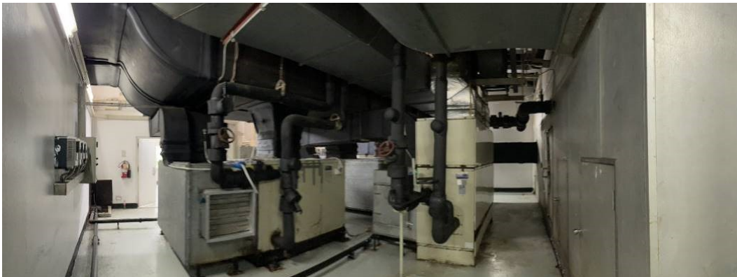
สภาพงานระบบภายในอาคาร-ห้องเครื่องเป่าลมเย็น 1 (A.H.U Room 1)
