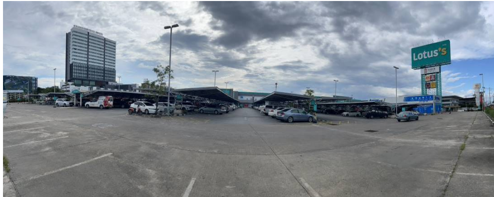
สภาพสิ่งปลูกสร้างอื่นๆ / ที่จอดรถยนต์ (หลังคาคลุม)
