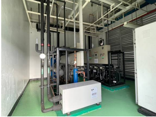
สภาพงานระบบภายในอาคาร-ห้องควบคุมระบบห้องเย็น (Compressor Room)
