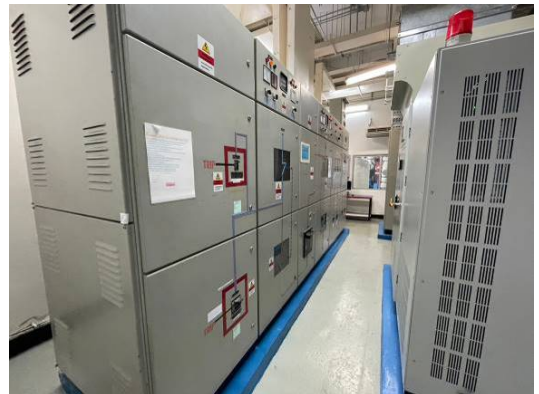
สภาพงานระบบภายในอาคาร-ห้องจ่ายกระแสไฟฟ้า (MDB Room)
