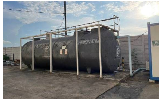
สภาพงานระบบภายนอกอาคาร-ถังบำบัดน้ำเสีย (Wastewater Treatment Tank)
