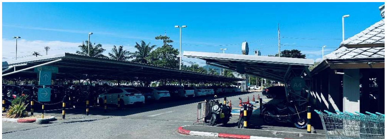
สภาพที่จอดรถภายในโครงการ
