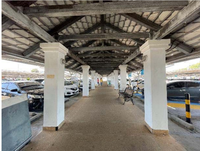
ส่วนโค้งหลังคาคลุมทางเดินภายในโครงการ
