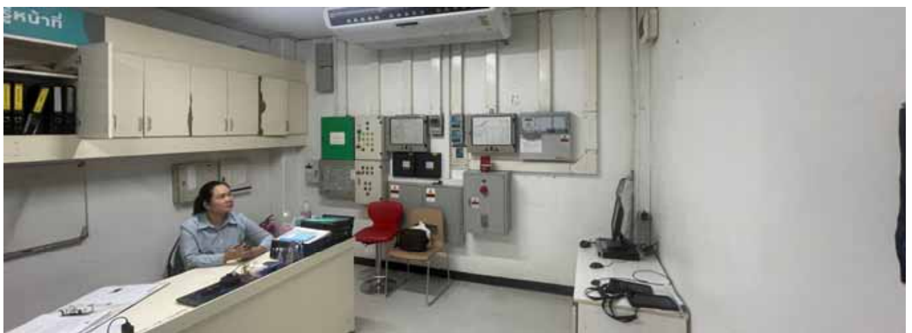
สภาพบริเวณพื้นที่ส่วนสำนักงาน (Back Office)
