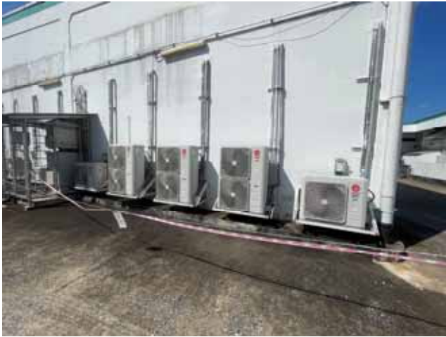
สภาพงานระบบปรับอากาศ (แบบแยกส่วน : Split Type)
