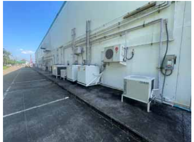
สภาพงานระบบปรับอากาศ (แบบแยกส่วน : Split Type)
