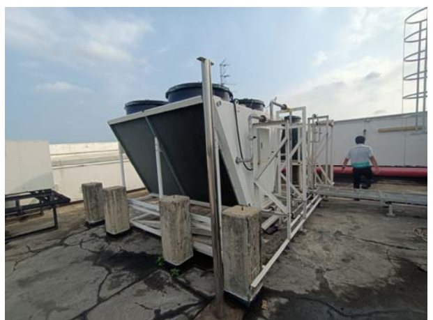
สภาพงานระบบปรับอากาศ (Air Cooled Chiller)
