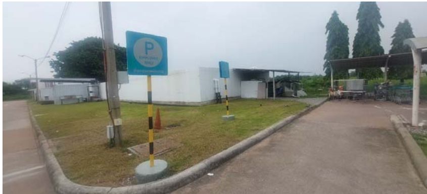
สภาพทั่วไปสิ่งปลูกสร้างรายการอื่นๆ / บ่อคอนกรีตเก็บน้ำเสีย
