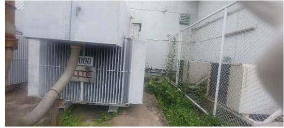
สภาพทั่วไปของระบบอาคาร หม้อแปลงไฟฟ้า 2000 KV
