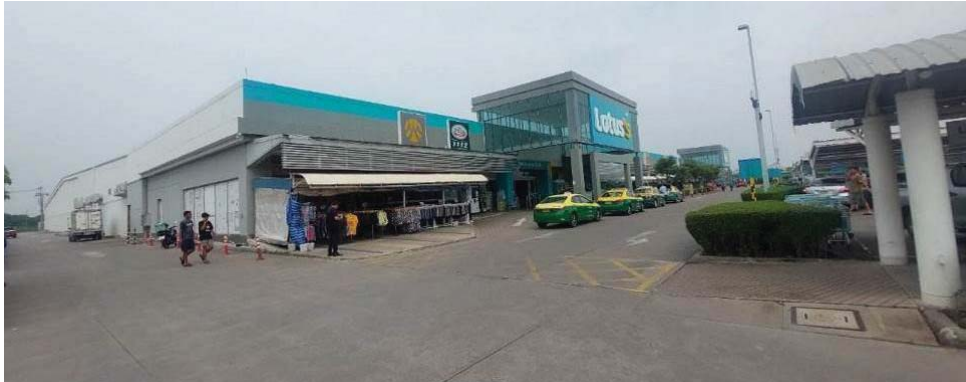
สภาพทั่วไปสิ่งปลูกสร้างรายการที่ 1 / อาคารเทสโก้โลตัสชั้นเดียว
