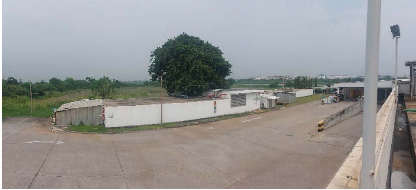
สภาพทั่วไปสิ่งปลูกสร้างรายการอื่นๆ / บ่อคอนกรีตเก็บน้ำดี
