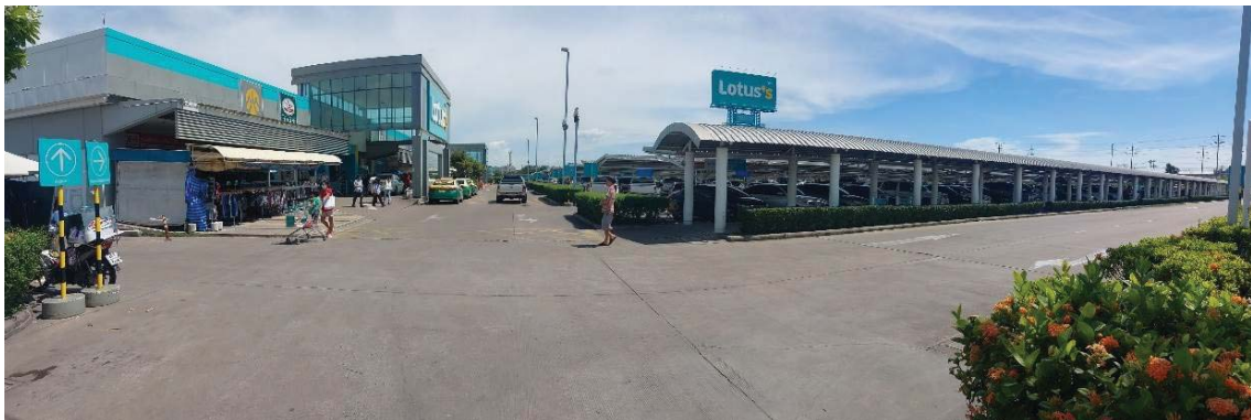
สภาพทั่วไปสิ่งปลูกสร้างรายการอื่นๆ / ส่วนหลังคาคลุม (จอดรถ)
