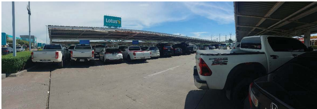
สภาพทั่วไปสิ่งปลูกสร้างรายการอื่นๆ / ส่วนหลังคาคลุม (จอดรถ)
