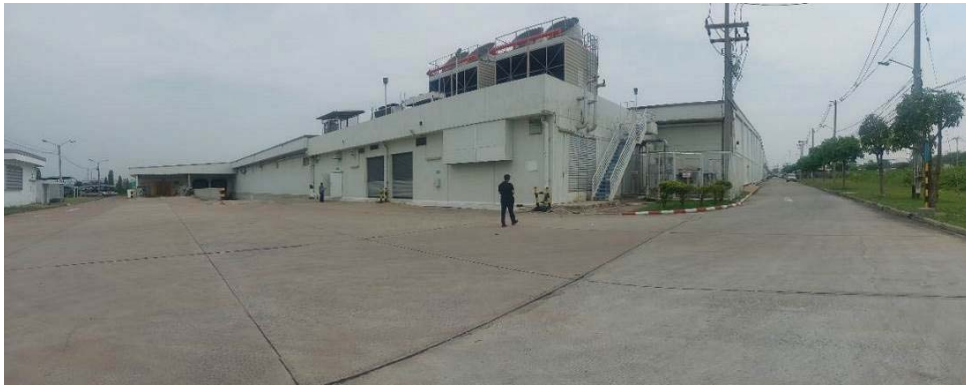
สภาพทั่วไปสิ่งปลูกสร้างรายการที่ 1 / อาคารเทสโก้โลตัสชั้นเดียว
