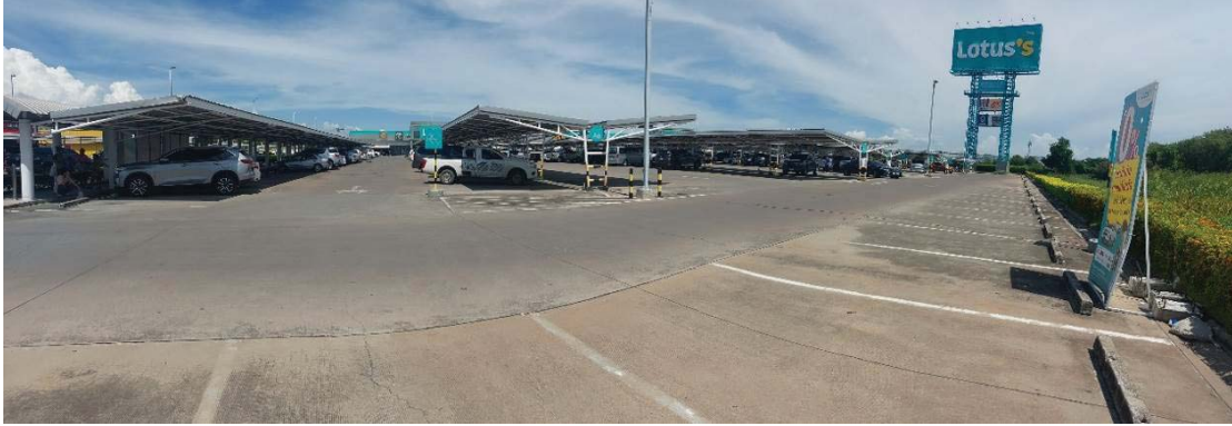
สภาพทั่วไปสิ่งปลูกสร้างรายการอื่นๆ / ลานคอนกรีต
