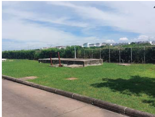
สภาพทั่วไปสิ่งปลูกสร้างรายการอื่นๆ / รั้วตะข่าย
