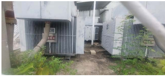
สภาพทั่วไปของระบบอาคาร หม้อแปลงไฟฟ้า 2000 KV
