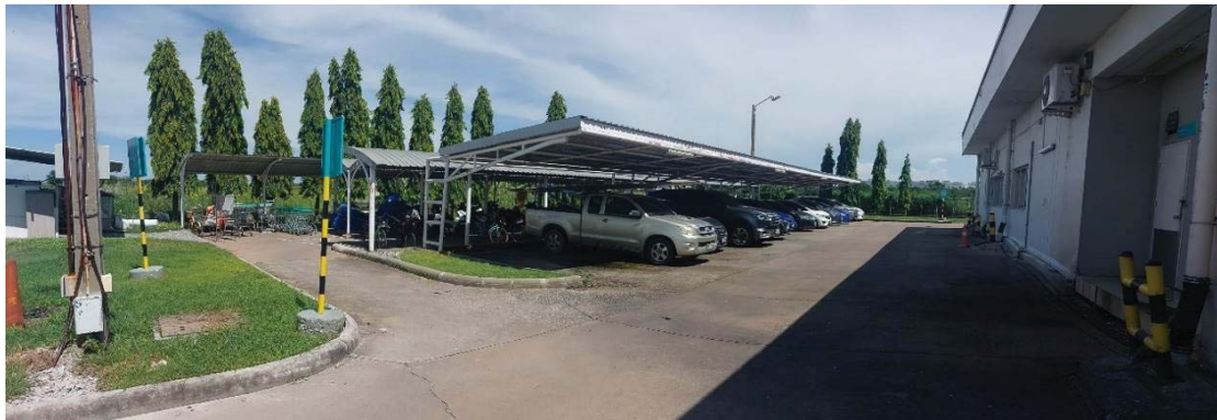
สภาพทั่วไปสิ่งปลูกสร้างรายการอื่นๆ / ส่วนหลังคาคลุม (จอดรถ)
