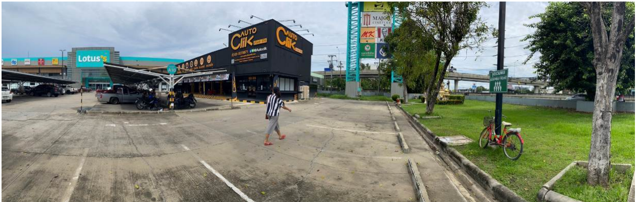
สภาพถนนและลานคอนกรีต
