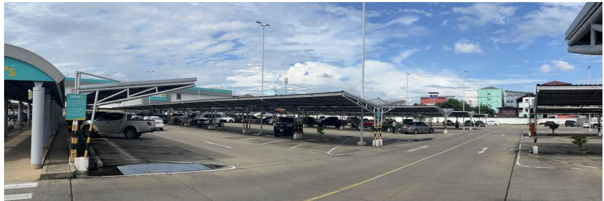
สภาพสิ่งปลูกสร้างอื่นๆ / ที่จอดรถหลังคาคลุม
