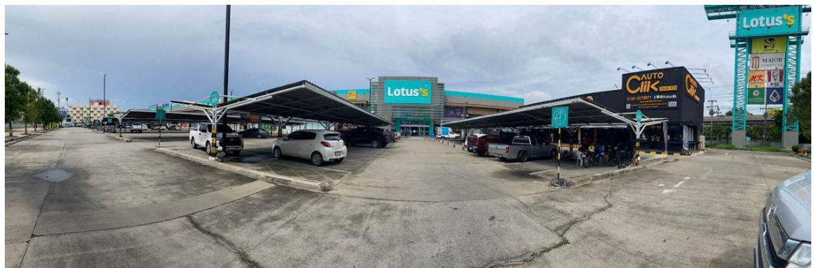
สภาพถนนและลานคอนกรีต
