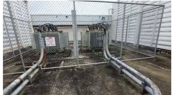
สภาพทั่วไปงานระบบอาคาร หม้อแปลงไฟฟ้า 2000 KV
