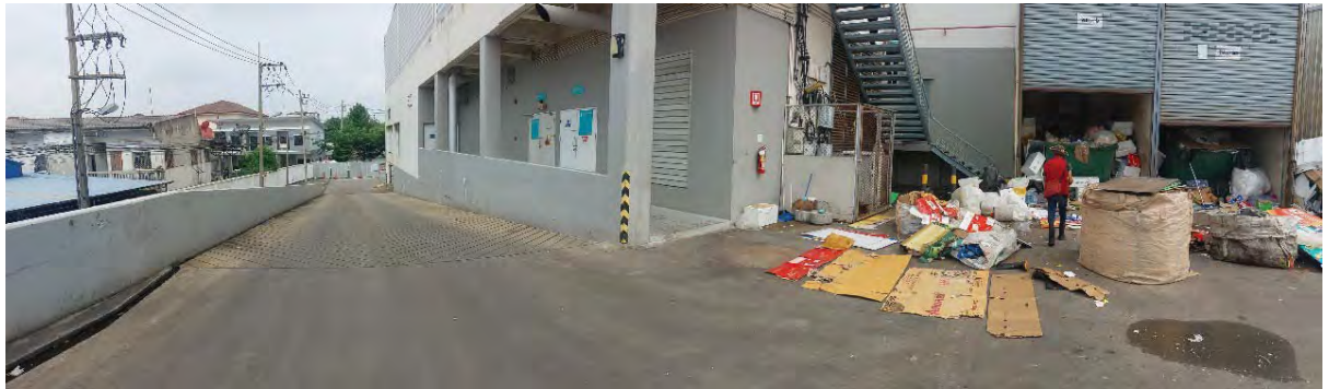
สภาพทั่วไปสิ่งปลูกสร้างรายการที่ 1
