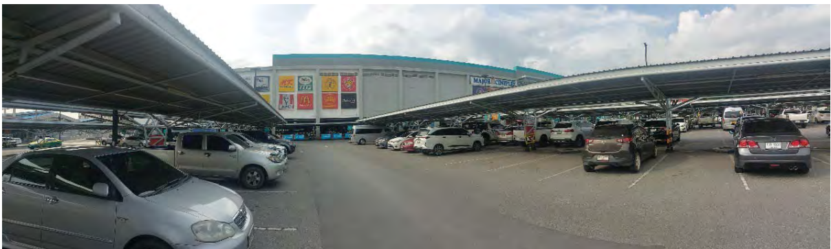
สภาพทั่วไปสิ่งปลูกสร้างรายการอื่นๆ หลังคาคลุมจอดรถ
