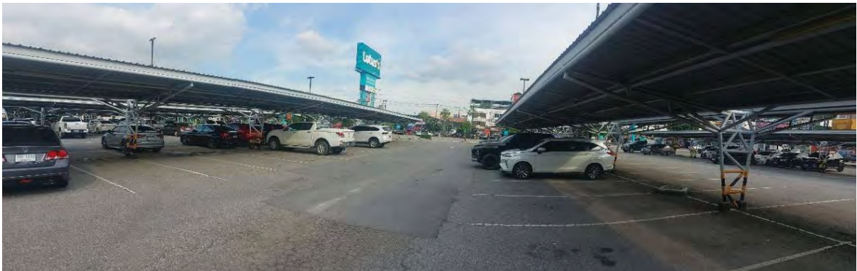
สภาพทั่วไปสิ่งปลูกสร้างรายการอื่นๆ หลังคาคลุมจอดรถ
