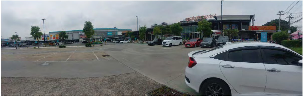
สภาพทั่วไปสิ่งปลูกสร้างรายการอื่นๆ / ถนนและลานคอนกรีต
