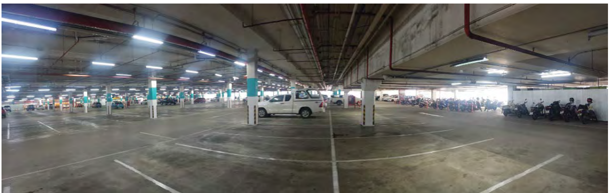
สภาพทั่วไปภายในสิ่งปลูกสร้างรายการที่ 1 / บริเวณส่วนพื้นที่จอดรถใต้อาคาร
