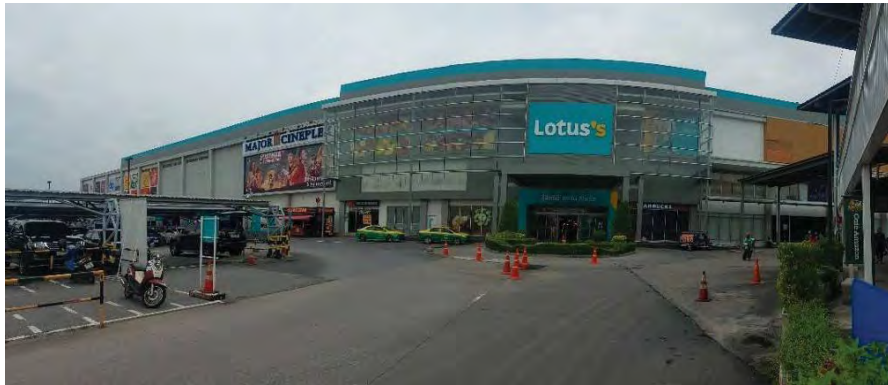
สภาพทั่วไปสิ่งปลูกสร้างรายการที่ 1 / อาคารโลตัส ไฮเปอร์มาร์เก็ต 2 ชั้น พร้อมชั้นลอย
