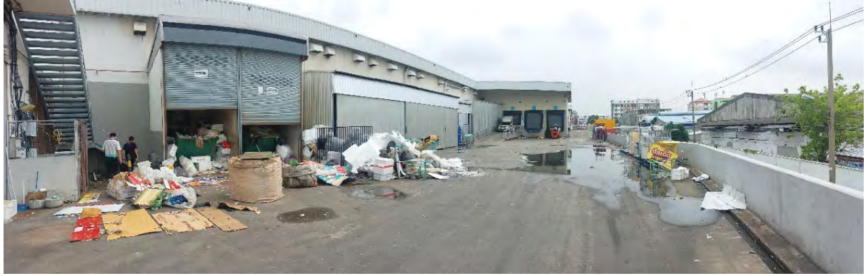
สภาพทั่วไปสิ่งปลูกสร้างรายการที่ 1
