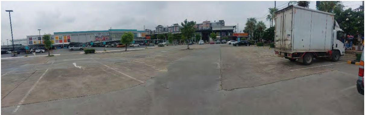
สภาพทั่วไปสิ่งปลูกสร้างรายการอื่นๆ / ถนนและลานคอนกรีต
