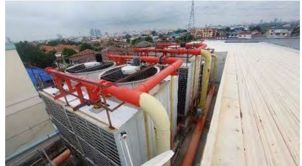
สภาพทั่วไปงานระบบอาคาร หอระบายน้ำเย็น (Cooling Tower)
