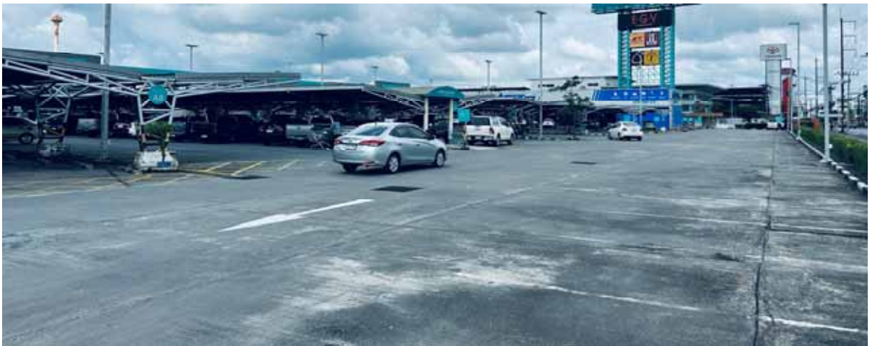
ลานคอนกรีต
