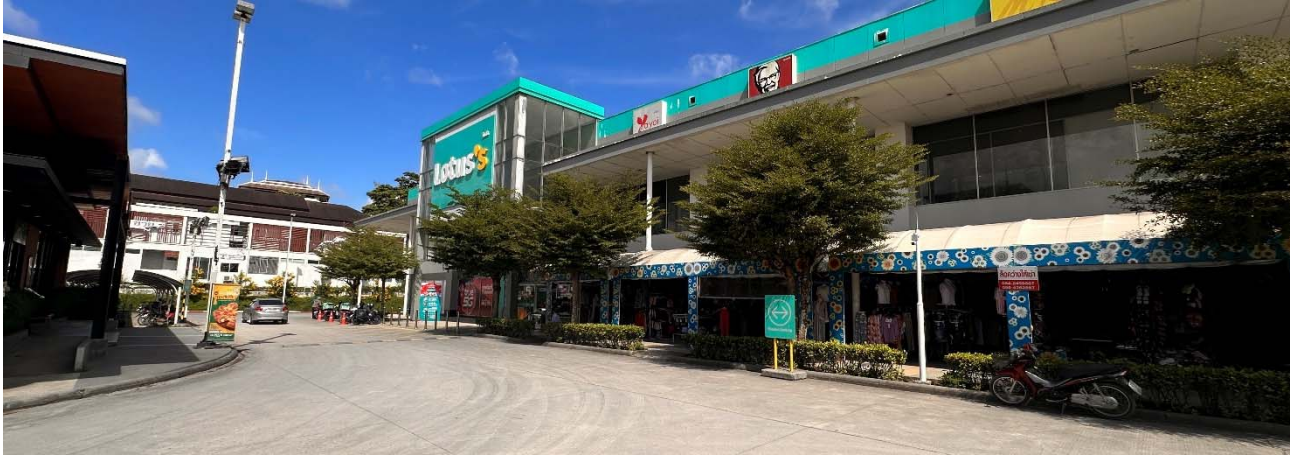
โครงการโลตัส ไฮเปอร์มาร์เก็ต สาขากระบี่
