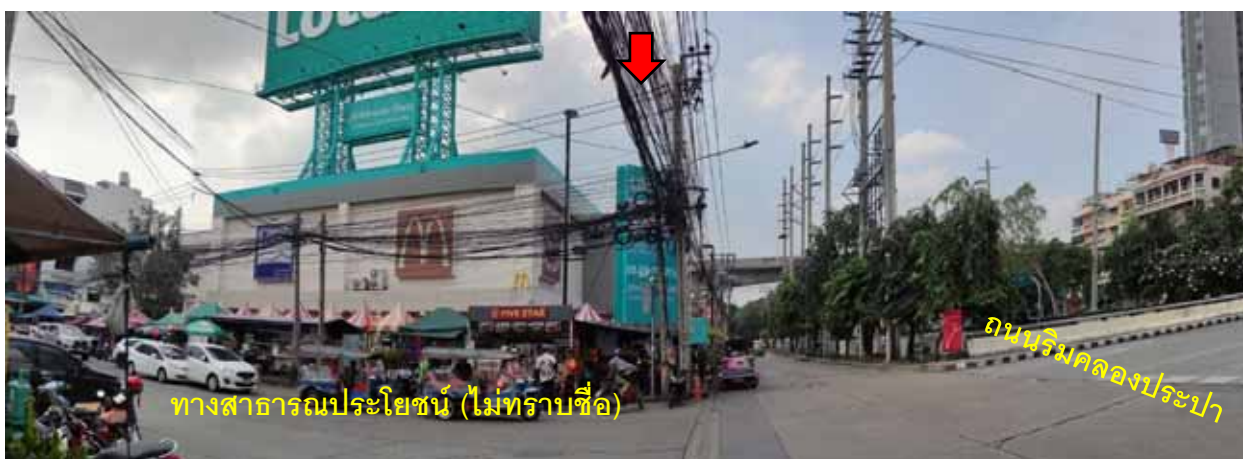
สภาพถนนริมคลองประปาและทางสาธารณประโยชน์ บริเวณด้านหน้าทรัพย์สินที่ประเมินมูลค่า (จุดถ่ายภาพที่ 3)
