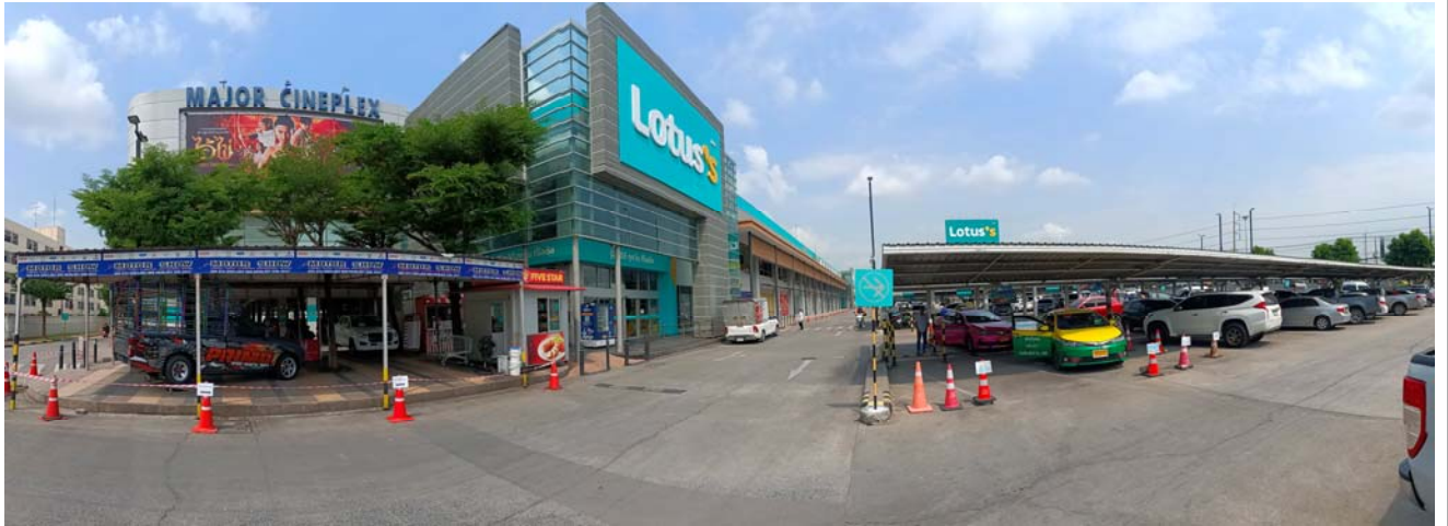
สภาพอาคารโลตัส ไฮเปอร์มาร์เก็ต สาขานวนคร (จุดถ่ายภาพที่ 13)
