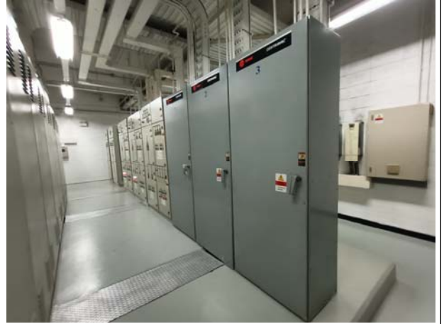
สภาพตู้ควบคุมระบบไฟฟ้า (MDB)
