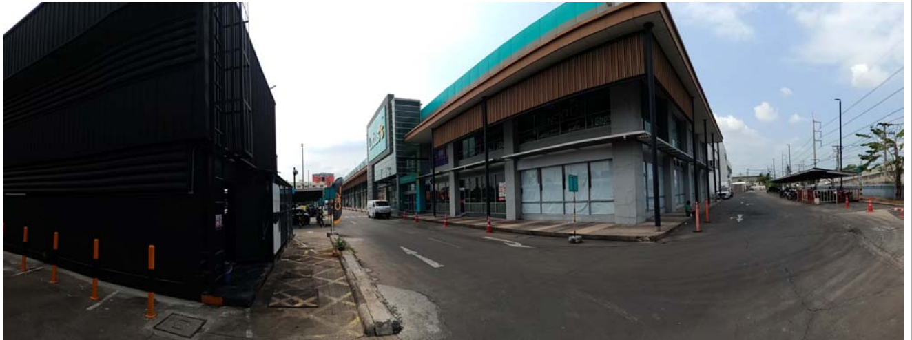
สภาพอาคารโลตัส ไฮเปอร์มาร์เก็ต สาขานวนคร (จุดถ่ายภาพที่ 14)
