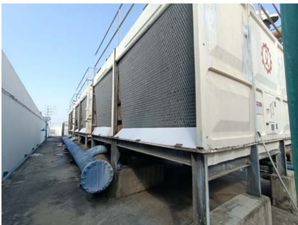
สภาพงานระบบปรับอากาศ (Cooling tower)
