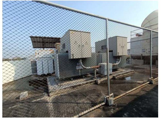
สภาพหม้อแปลงไฟฟ้า (transformer)
