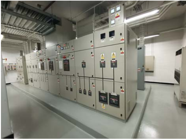
สภาพตู้ควบคุมระบบไฟฟ้า (MDB)
