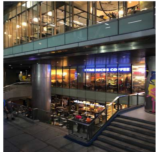
ภาพทั่วไปด้านหน้าอาคาร
