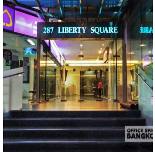
สภาพทั่วไปด้านหน้าอาคาร
