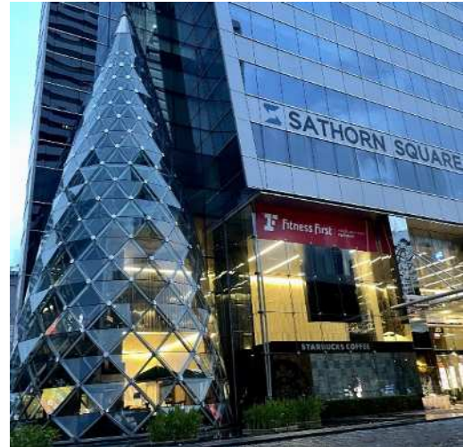
สภาพทั่วไปด้านหน้าอาคาร
