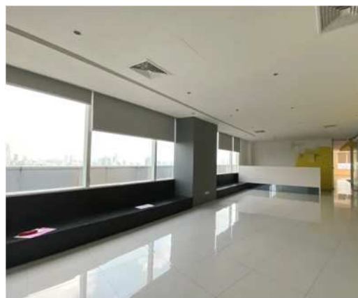
สภาพทั่วไปภายในอาคาร
