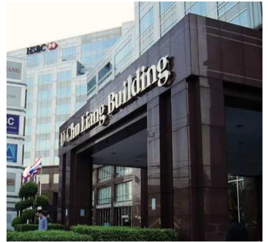
สภาพทั่วไปบริเวณด้านหน้าอาคาร
