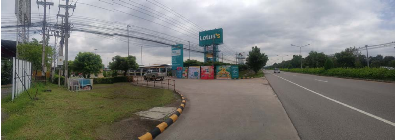
สภาพถนนสระบุรี-หล่มสัก (ทล. 21) บริเวณผ่านหน้าทรัพย์สินที่ประเมินมูลค่า (จุดถ่ายภาพที่ 1)
